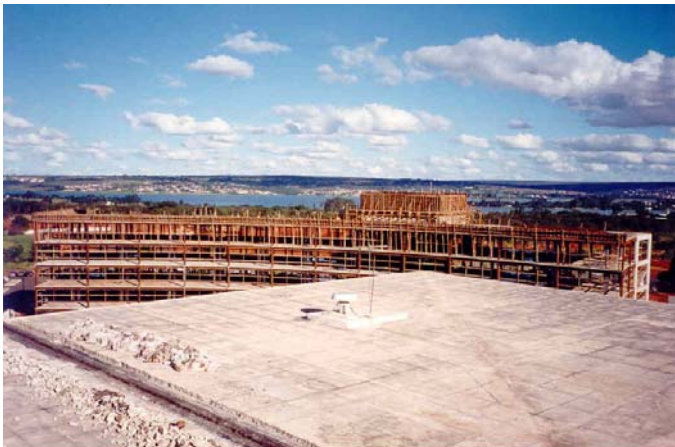
◀ Detalhe de uma cobertura em construção.
