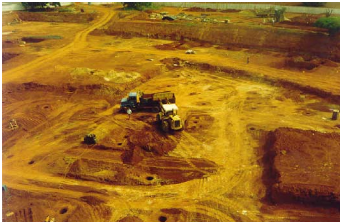
◀ Vista da execução da terraplenagem de uma futura instituição pública
